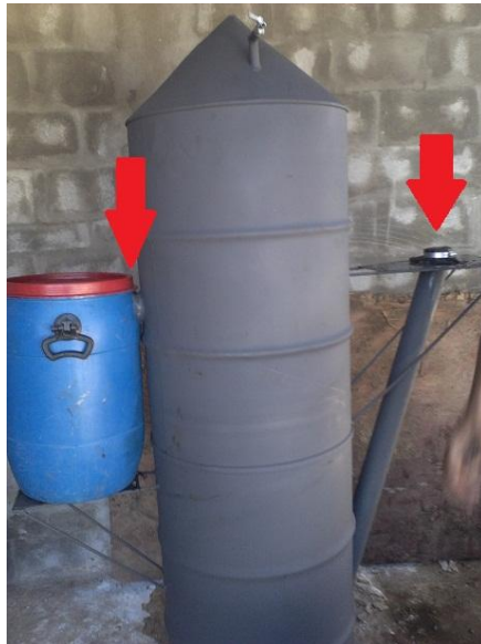
Figura 03- Biodigestor piloto com escape de gás na caixa de saída.
