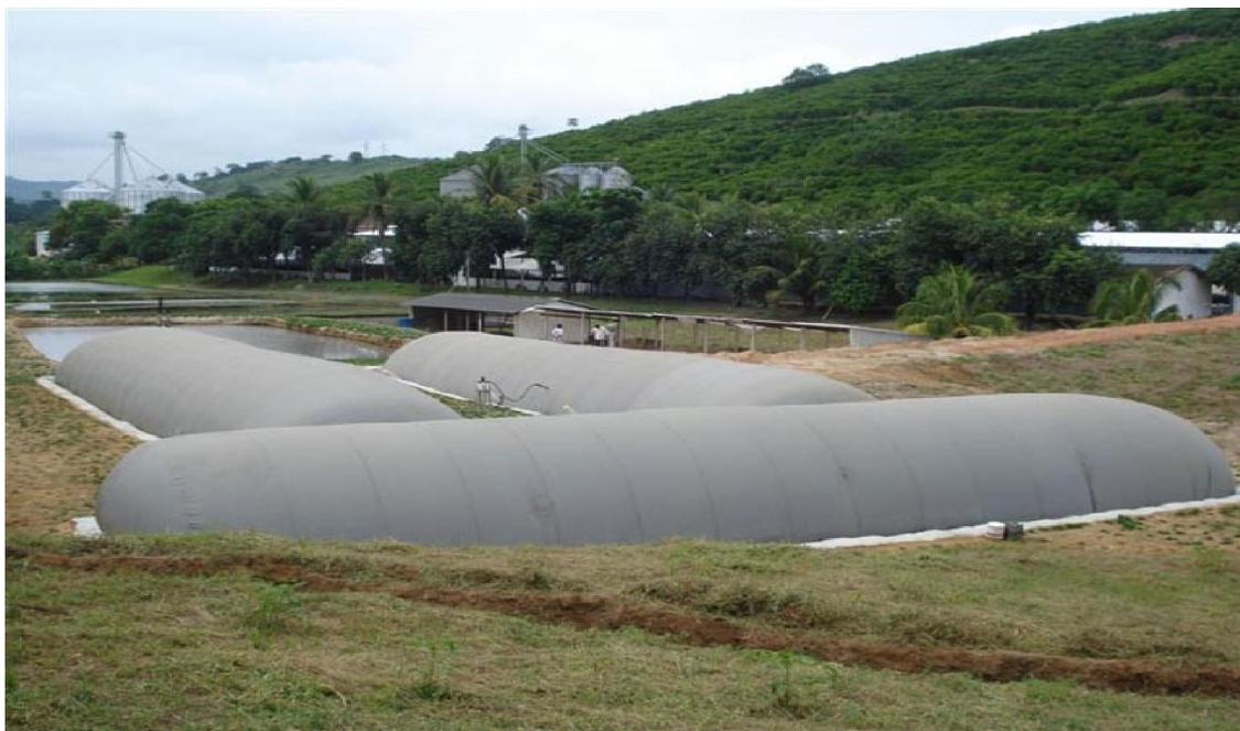
Figura 5- Modelo Canadense de Biodigestor. Fonte: Arcevo UFMG
