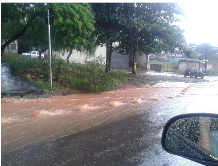
Figura 02: enxurrada devido à falta de permeabilização localizada na Av. Goiás, sentido Vila Fabril. Fonte: Rodrigues 2014
