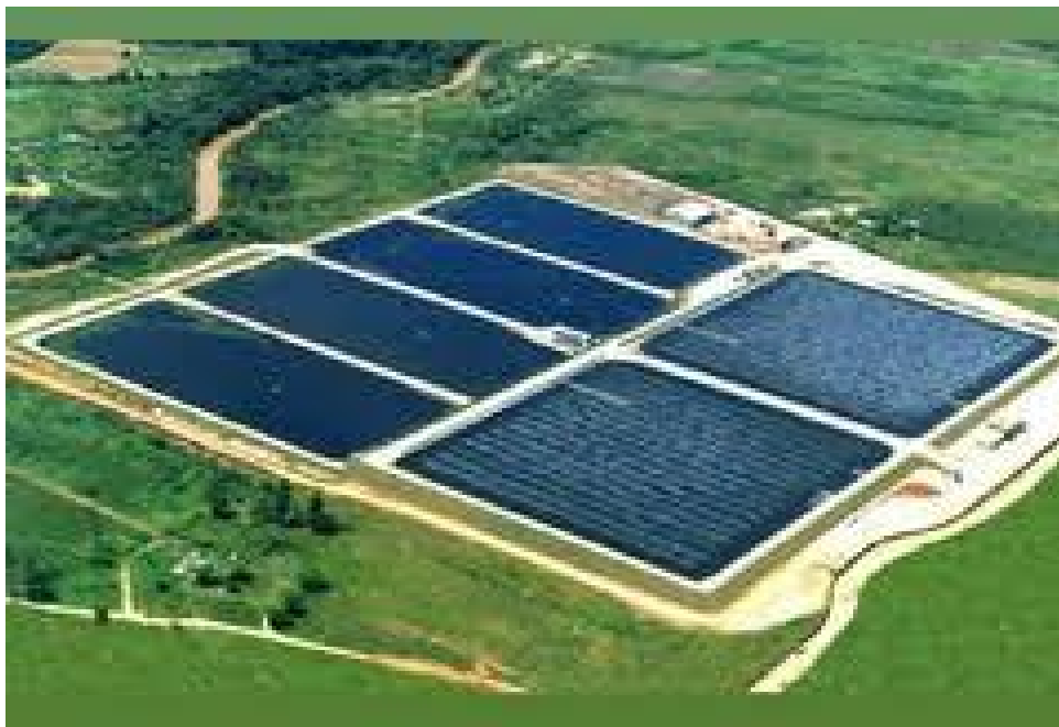
Figura 2: Lagoas de Estabilização
