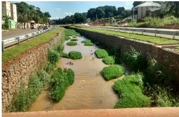
Figura 06: Ligação da Rua Engenheiro Portela com o Central Park. A obra já foi concluída. Foi realizada as instalações de gabiões para contenção da velocidade das águas, bem como, o alargamento do curso do rio naquela área.
