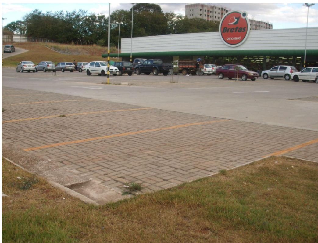
Figura 8 - Pavimentação do estacionamento em paver / Fonte: Oliveira 2013
