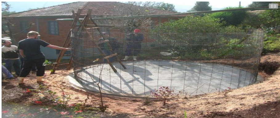
Figura. 8: Construção utilizando ferrocimento Fonte: http://www.coopertecti.com.br/2016
