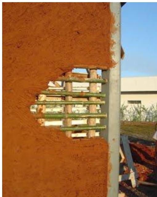
Figura 4. Parede de Taipa de mão (Pau a pique).
