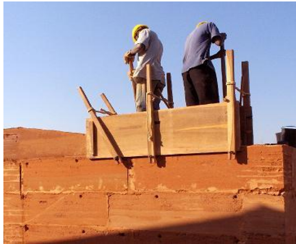
Figura 5. Confeção de paredes de Taipa de Pilão Fonte: http://www.recriarcomvoce.com.br/2015
