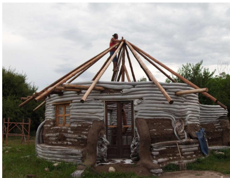
Figura 1. Construção em Superadobe.
