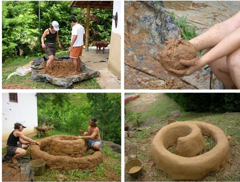
Figura 3. Construção utilizando COB.
