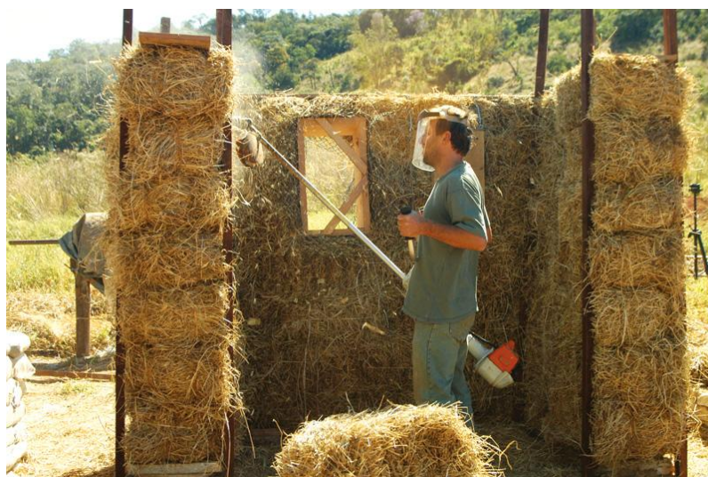
Figura 7. Construção com Fardos de Palha Fonte: http://www.ecocentro.org – IPEC/2016
