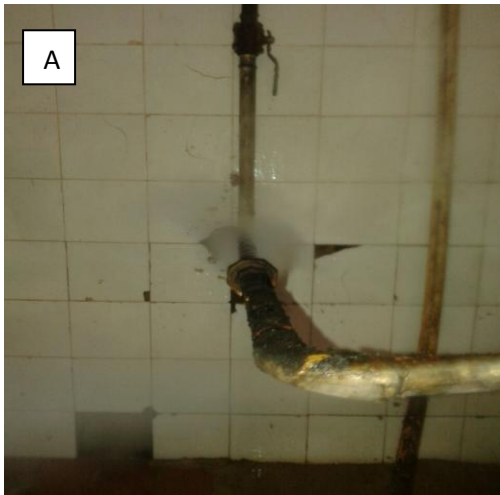
Figura 7. Entrada de vapor dos tachos. A: Vazamento na tubulação. B: Vazamento Solucionado.
