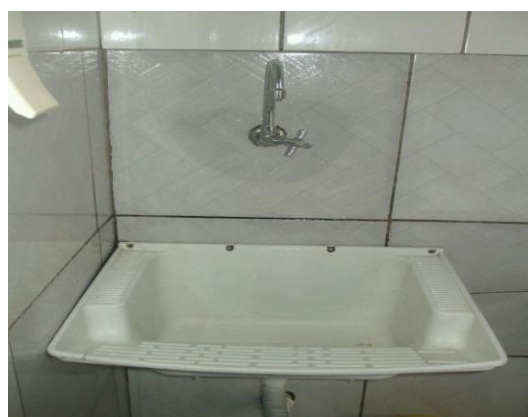
Figura 6. Pia com torneira substituída.
