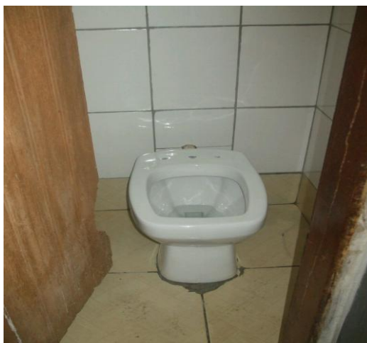
Figura 4. Substituição dos vasos sanitários.
