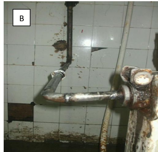
Figura 7. Entrada de vapor dos tachos. A: Vazamento na tubulação. B: Vazamento Solucionado.
