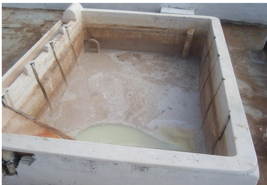
Figura 11 – Caixas de remoção e separação de gorduras. Fonte: Ferreira (2013)
