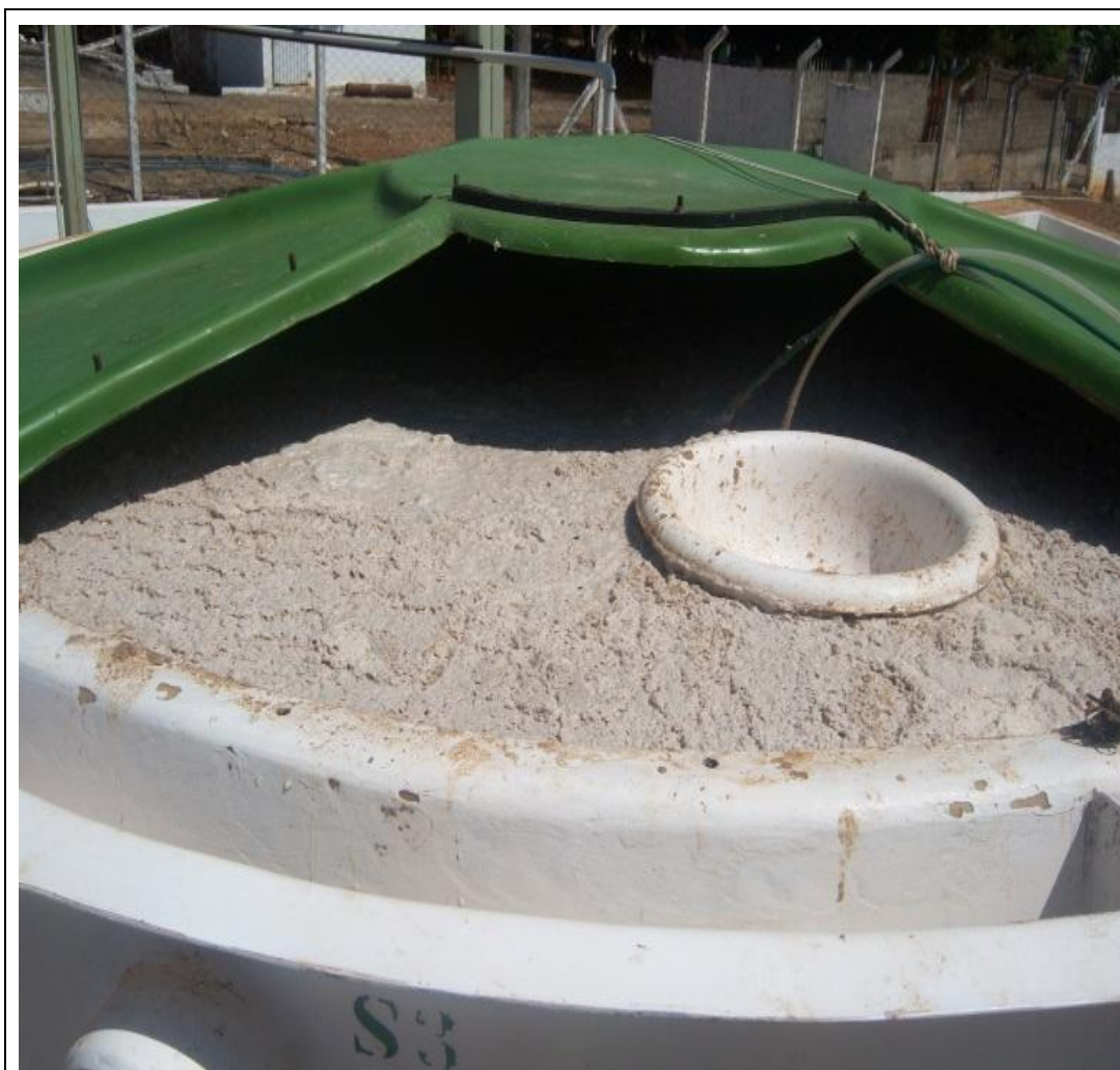
Figura 07 – Processo de flotação do laticínio “Glorioso”. Fonte: Ferreira (2013)
