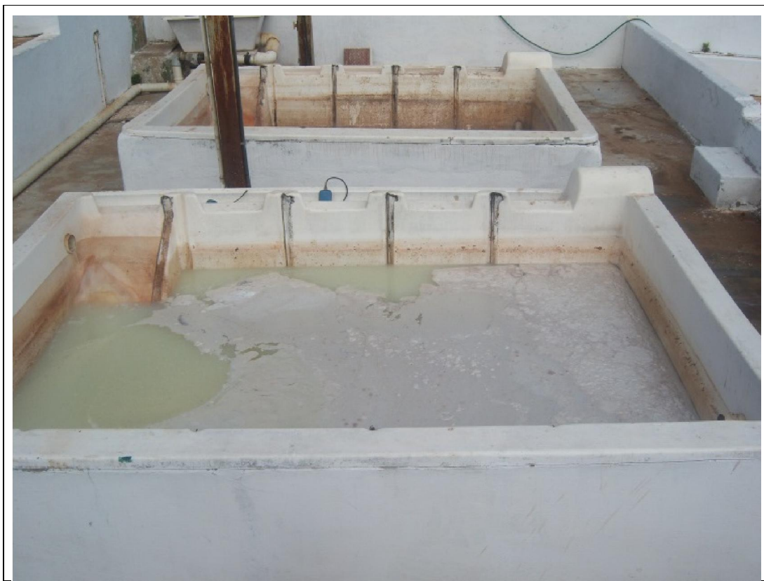
Figura 10 – Caixas de remoção e separação de gorduras. Fonte: Ferreira (2013)
