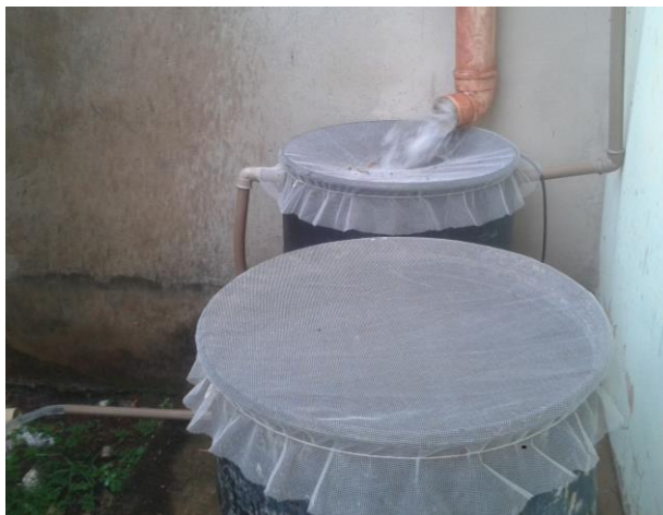
Figura 3: Tambores para armazenamento da água de chuva. Fonte: CARDOSO, 2017.
