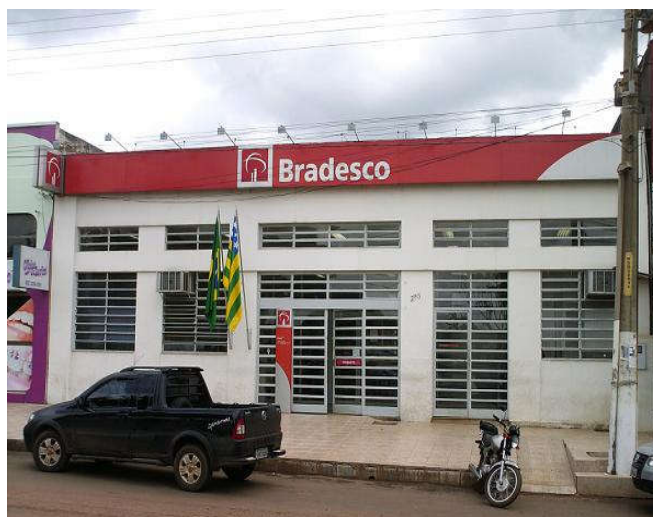
Entrada da Agência 0611-4 do Bradesco S/A
