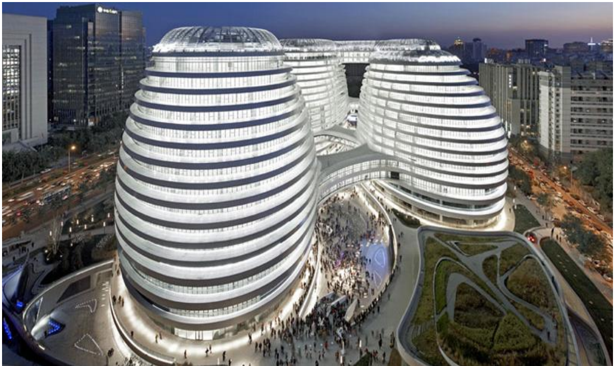
Figura 49. Desenho arquitetônico do Complexo Cultural em Pequim-China. Projeto da arquiteta Zaha Hadid. Arquitetura Contemporânea.
