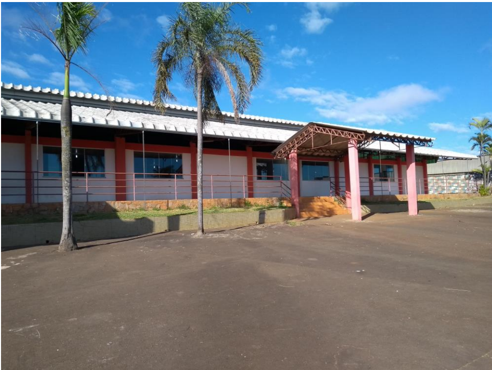
Figura 14 – vista da fachada da escola
