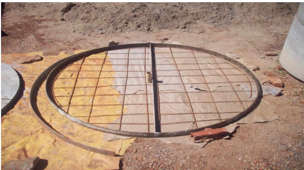
Figura 02 – Ferramenta utilizada para produzir tampas de fossas
