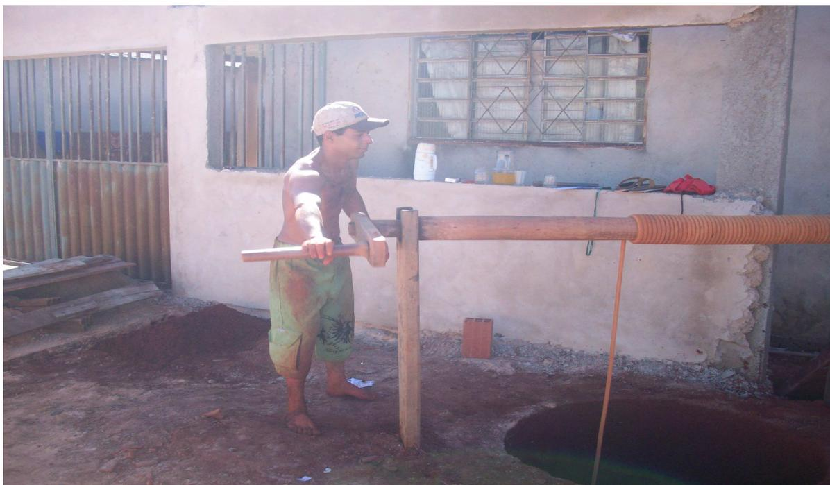
Figura 03 – Ferramenta utilizada para perfurar fossas
