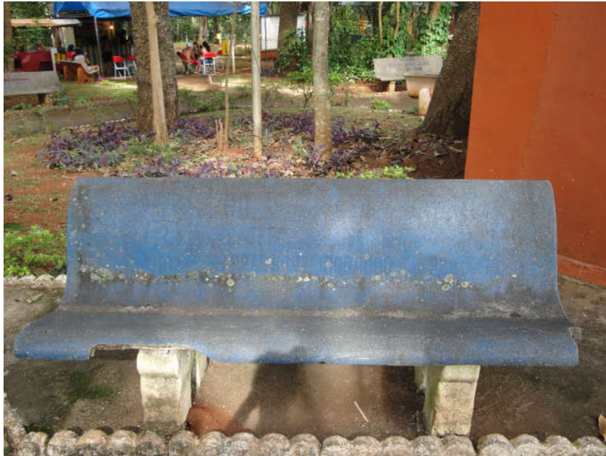
Figura 3 – Bancos quebrados, pintura desgastada.
