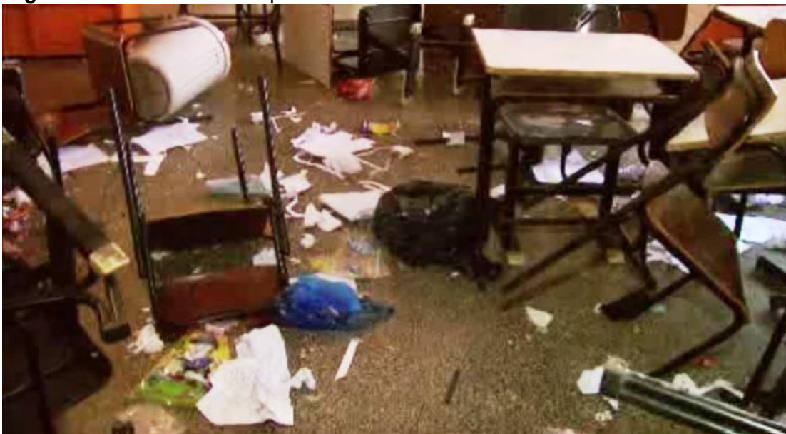
Figura 1 – Escola Infestada por roedores e insetos no Distrito Federal
