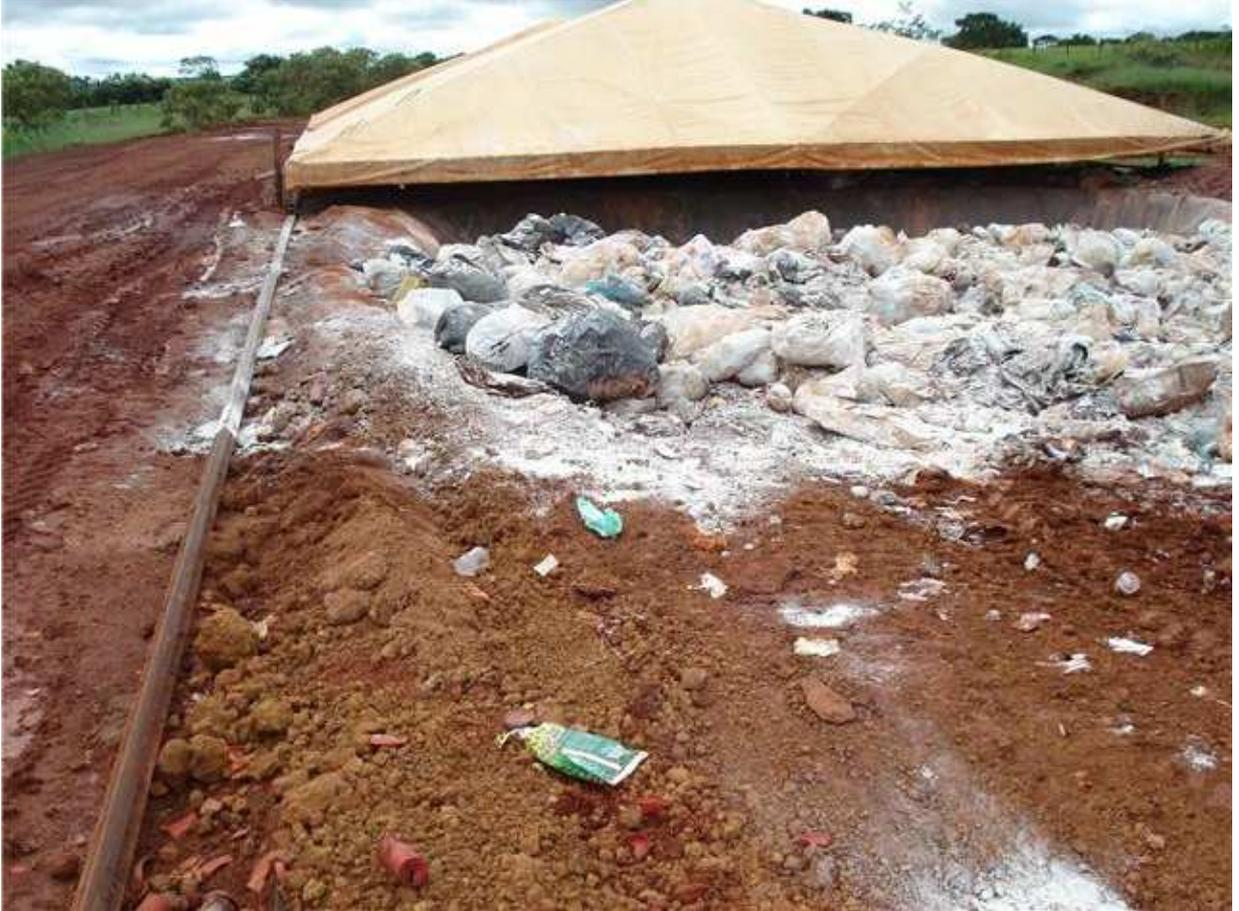
Figura 9 - Adição de cal sobre os RSS no Aterro Sanitário de Anápolis - GO.
