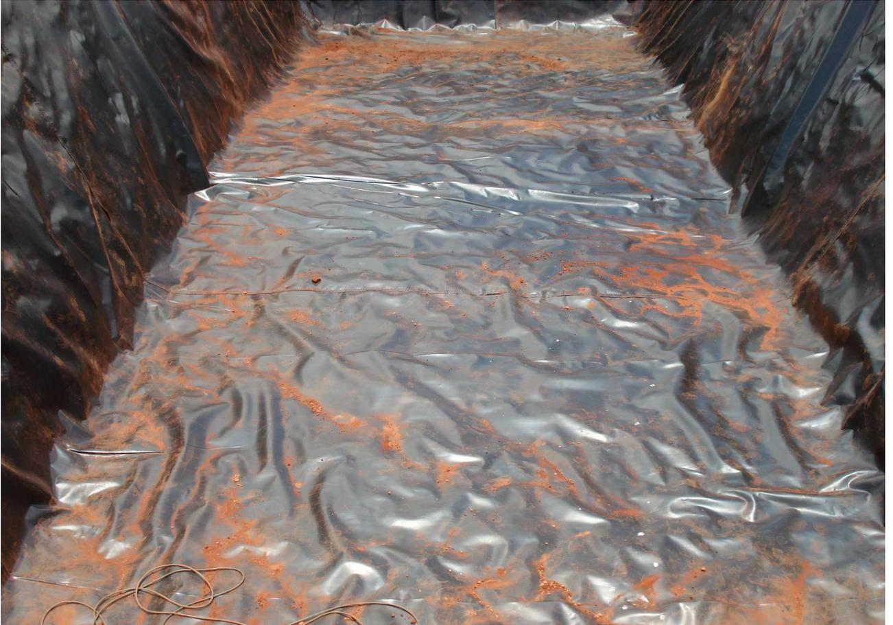
Figura 7 - Vala pronta para depósito de RSS no Aterro Sanitário de Anápolis - GO.
