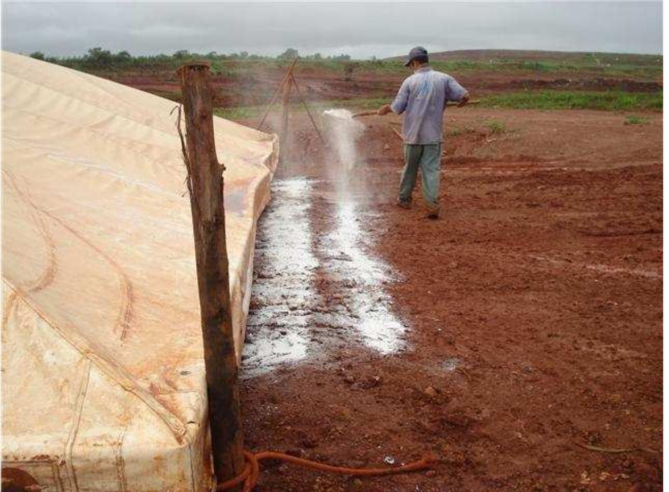
Figura 10 - Adição de cal nas bordas da tenda no Aterro Sanitário de Anápolis - GO.
