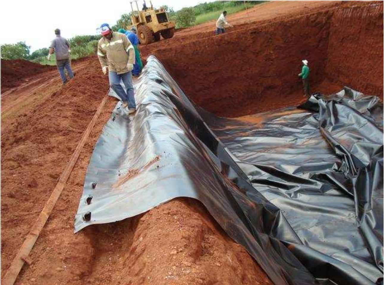
Figura 6 - Processo de isolamento da Vala no Aterro Sanitário de Anápolis - GO.
