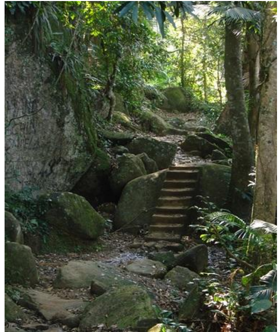
Figura 4 – Escada esculpida na pedra.
