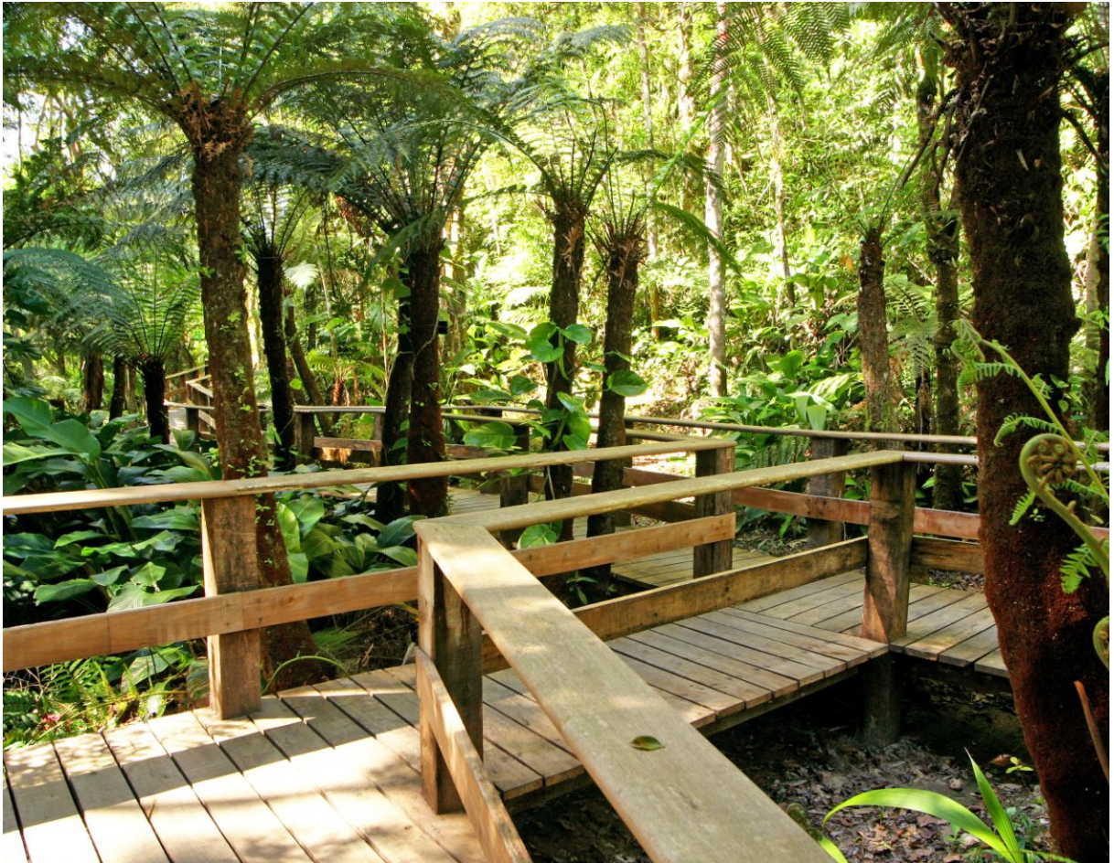
Figura 2 – Estrutura construída em madeira.
