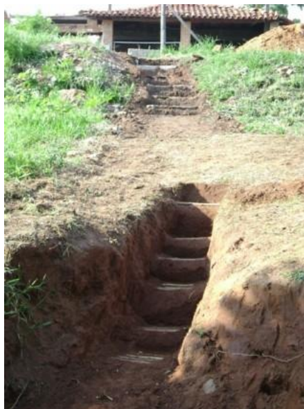
Figura 5 – Escada estreita construída no solo.
