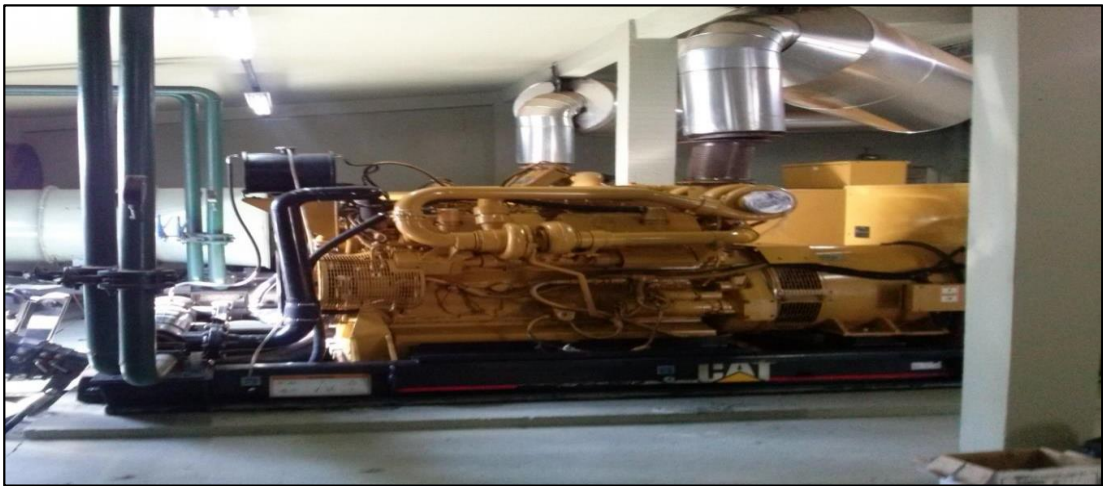
Figura 5 - Analisando melhor forma de remoção do Gerador da área de operação.
