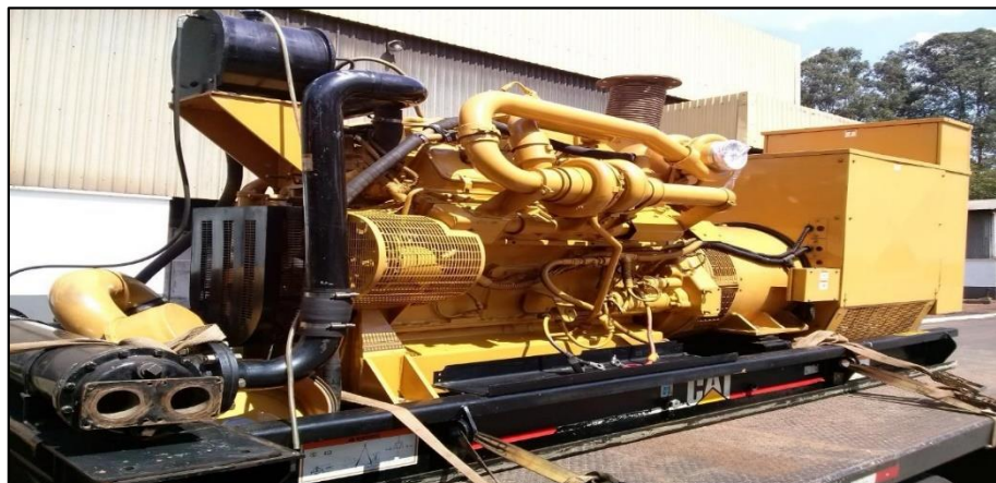
Figura 6 - Equipamento já removido e autorizado para transporte.
