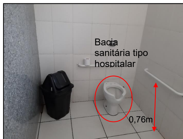
Figura 37- Área interna do box
