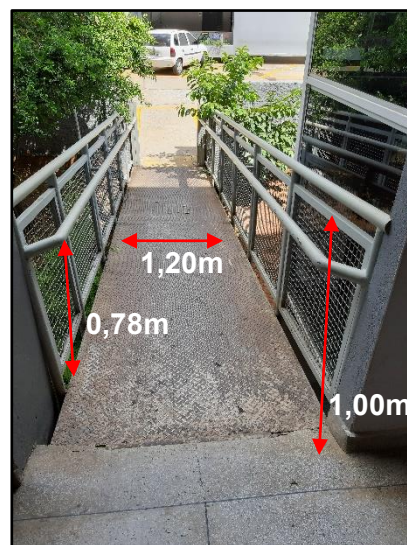
Figura 30- Rampa do bloco B
