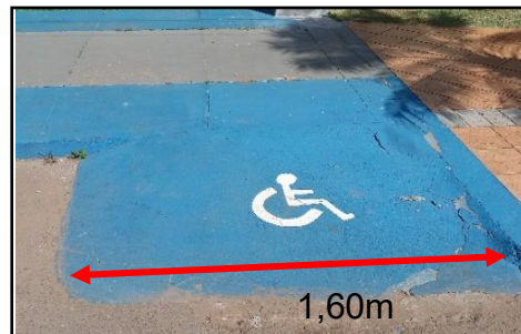
Figura 10- Detalhe da rampa 2
