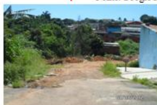
Figura 3: Fim do asfalto na Rua Xavantes
