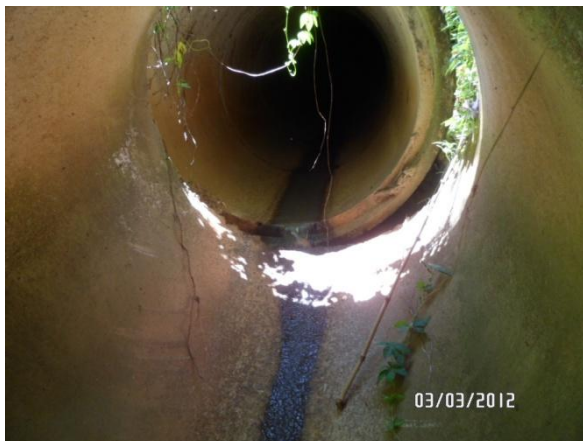
Figura 12: Ligação da rede pluvial
