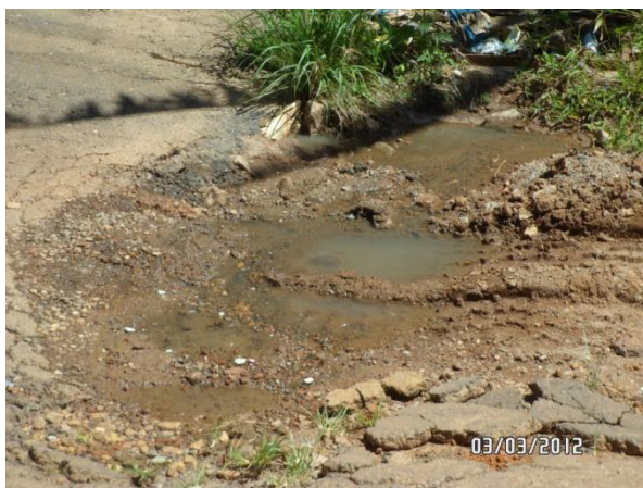
Figura 10: Cano de esgoto estourado
