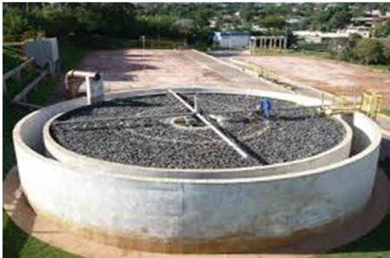
**Figura 3:** Filtros Biológicos para Tratamento de Esgoto.
