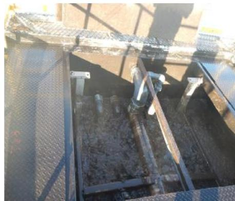
**Figura 09:** Tanque de Membranas. Fonte: Do autor
